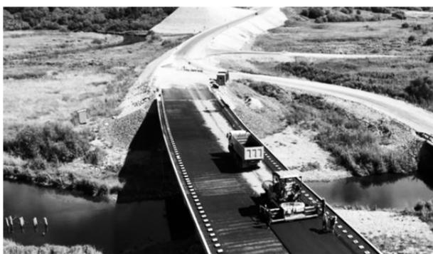
новые водопропускные трубы, обустроил земляное полотно, укрепил кюветы. Идут работы по устройству асфальтобетонного покрытия на автодороге и на новых мостовых переходах через реки Белинская, Каменишка и Парусная. На участках сделают наружное освещение, тротуары с перильным ограждением, автобусные остановки с заездными карманами и автопавильонами, пешеход-
