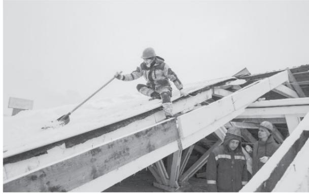
Шахтерске ведется подготовка к монтажу нового железобетонного основания для крепления стропильной решетки. А в Углегорске уже восстановлена целостность двух кровель многоквартирных домов.
